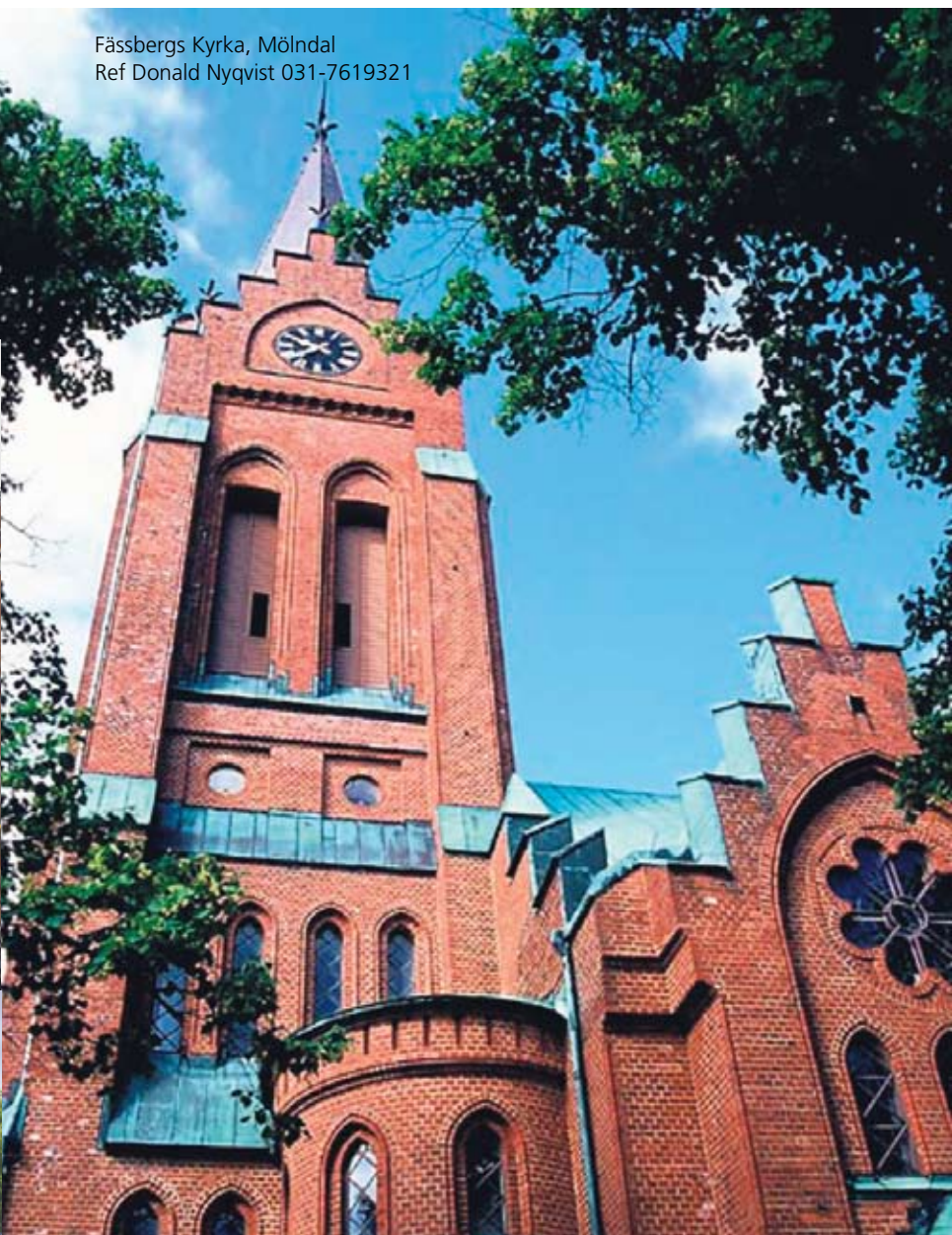
Tösse Kyrka i Värmland Ref. Bo Karlsson 0705-713500 Bara några år efter förra fasadrenoveringen började fasaden på Tösse Kyrka att falla av i stora sjok. Sedan Nordisk Stenimpregnering renoverat kyrkan med Kalkstark motstår den tidens tand.
